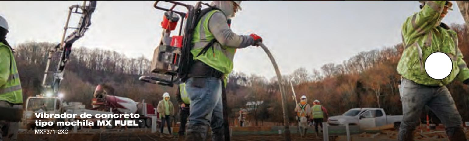
**Vibrador de concreto tipo mochila MX FUEL™**
